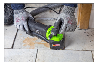
ponçage de colle de carrelage
