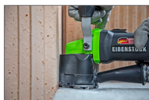
Ponçage au ras des murs
