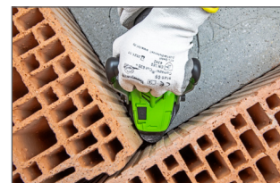
Ponçage dans les angles
